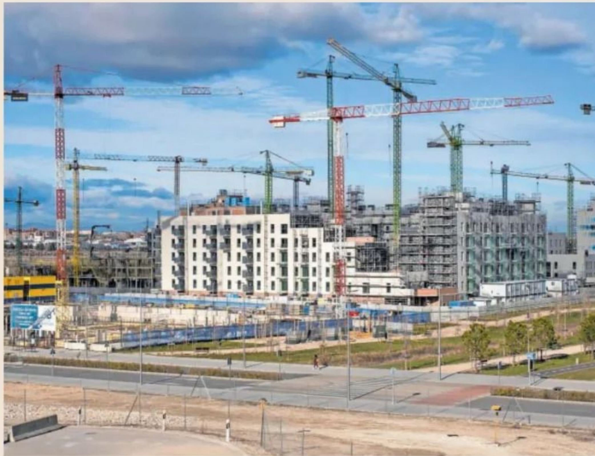
Grúas de construcción en Madrid, el pasado enero.
