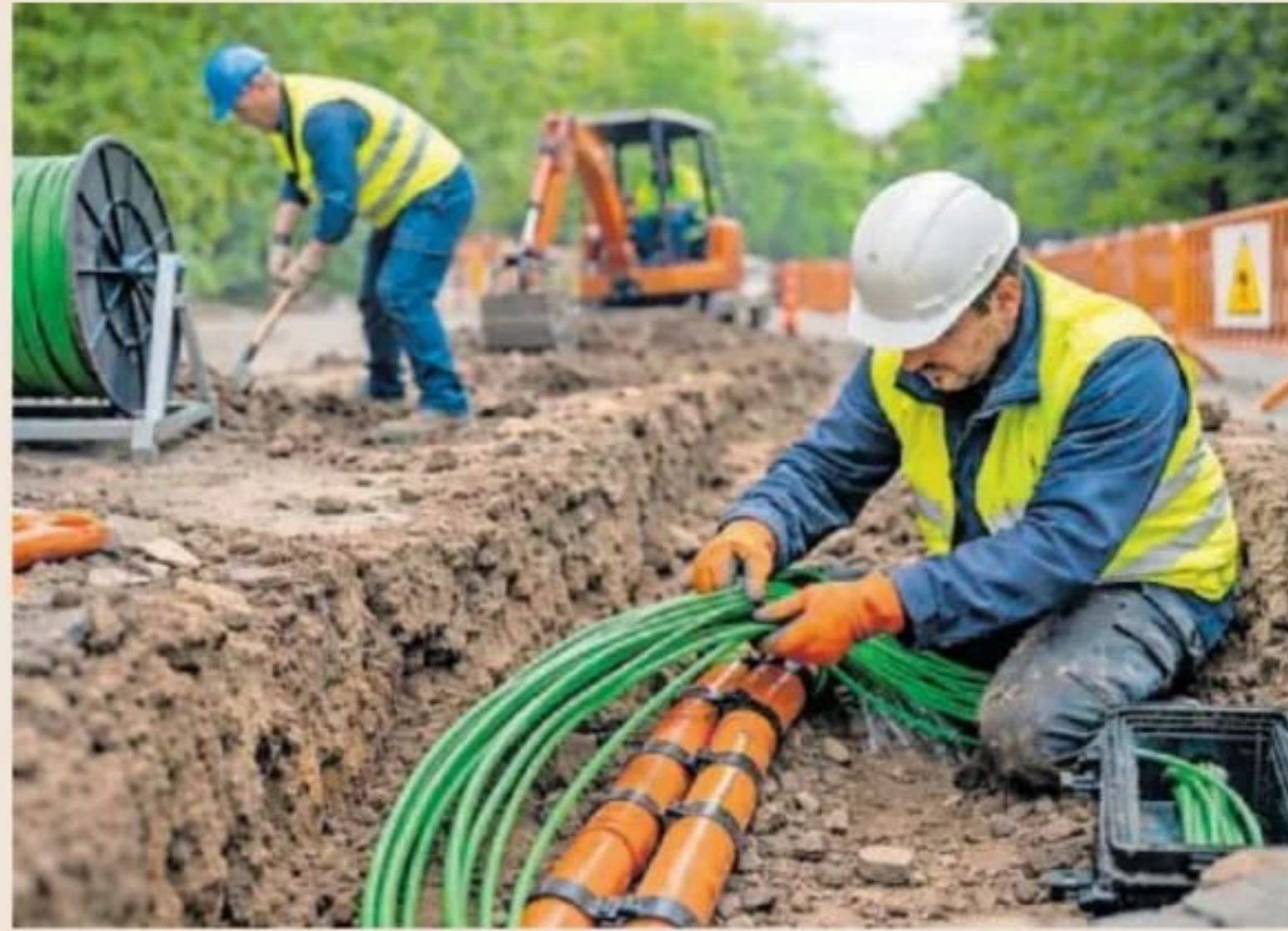
Operarios tienden cables de fibra óptica en Vitoria.
